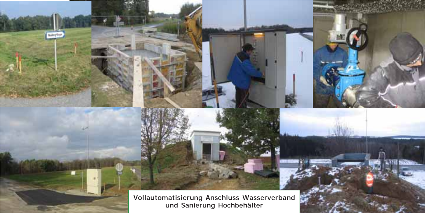
Instandhaltung und Erweiterung Wasserleitung
