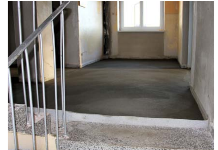
Obergeschoss: Blick in Richtung ehemaliger Balkon, Estrich fertig
