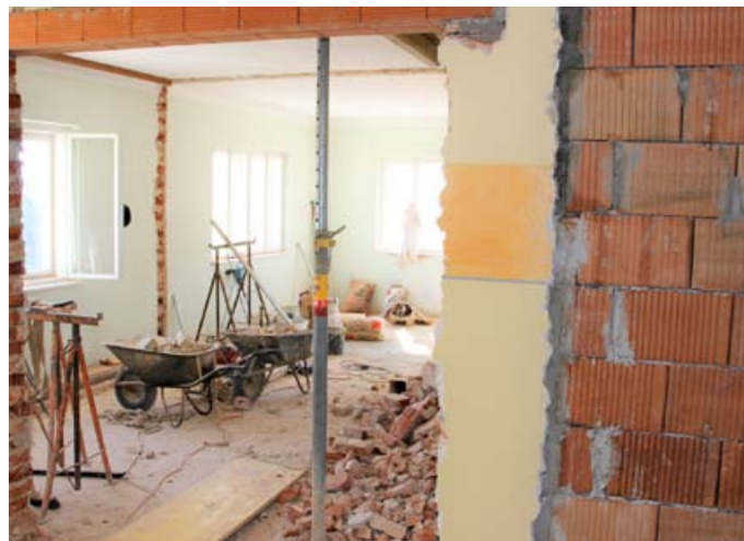
Sitzungs- und Trauungssaal Obergeschoss: Abbrucharbeiten
