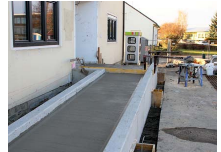
Außenanlage: Fertig betonierte Rampe
