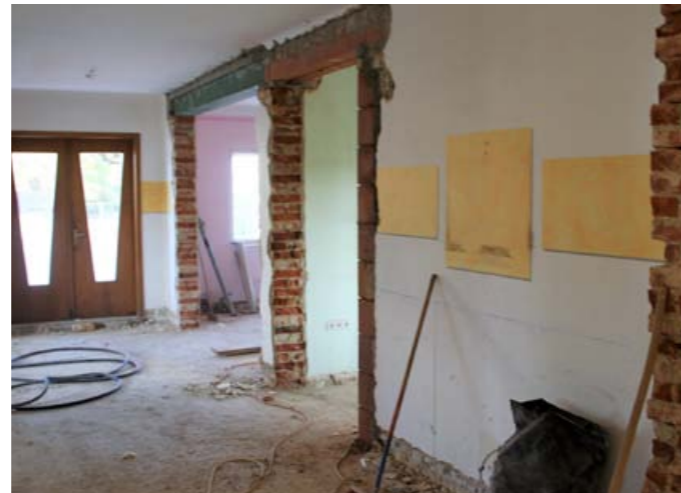
Abbrucharbeiten Eingangsbereich: Böden entfernen, Unterzüge einziehen, Vorarbeiten für Glasportale
