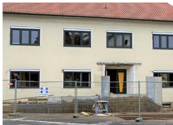
Frontansicht: neue Fenster, Schalung der Rampe, Vordach abgerissen
