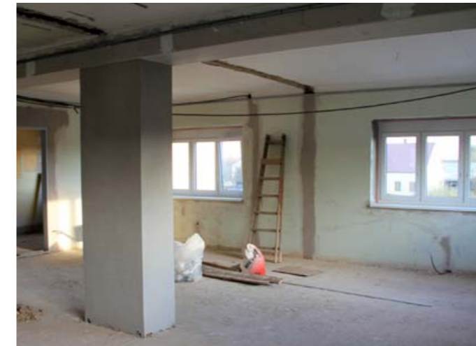
Sitzungs- und Trauungssaal: Fertig verputzt, vorbereitet für Estrich
