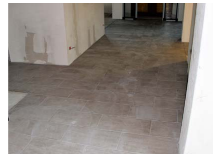
Fliesenlegerarbeiten im Eingangsbereich
