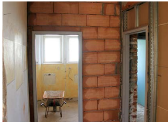
WC Erdgeschoss: links das Damen- und behindertengerechte WC, rechts das Herren-WC
