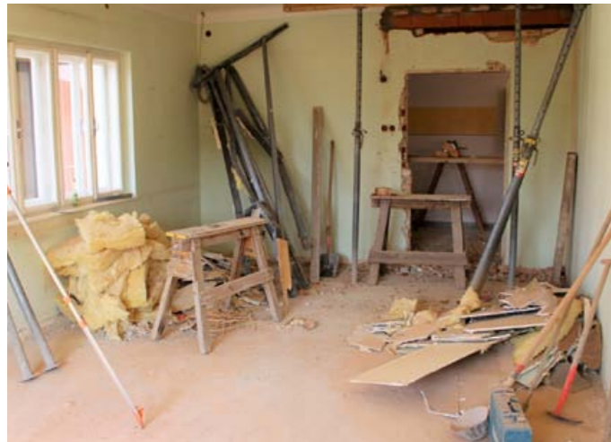
Abbrucharbeiten Büros: Böden entfernen, Unterzüge einziehen, Tüerstöcke ausreißen bzw. Wände abbrechen (Büro Bürgermeister, Sozialraum)
