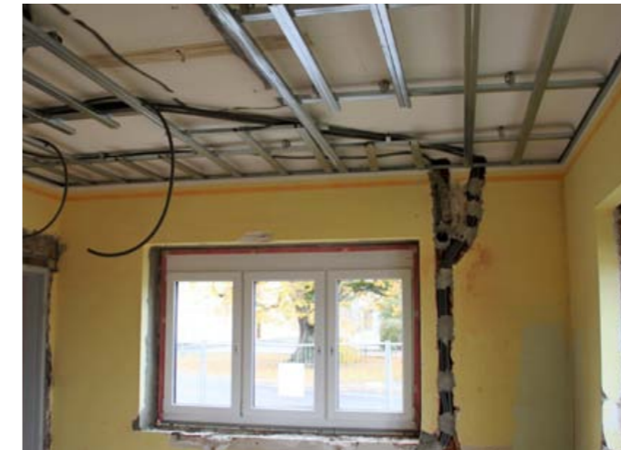
Büro Erdgeschoss: Gerüst für abgehängte Decke, eingezogene und eingestemte Elektroleitungen sowie neuer Türrahmen und neues Fenster
