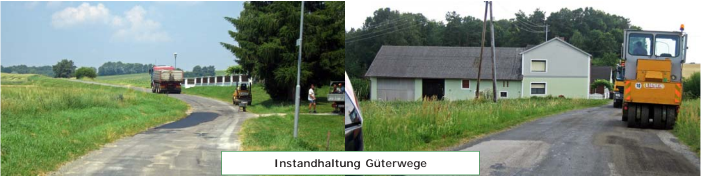
Sanierung Bäche, Beseitigung Hochwasserschäden
