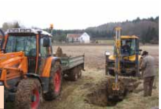
Hausanschlussarbeiten Wasser, Kanal
