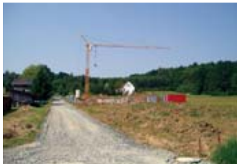
Baubeginn Wohnhausanlage Matthias Semmeliker Gasse in Unterneuberg
