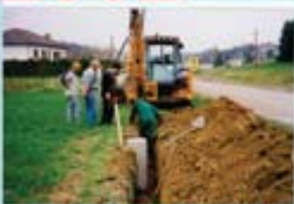
Kabelverlegung Strassenlicht Gewerbegebiet
