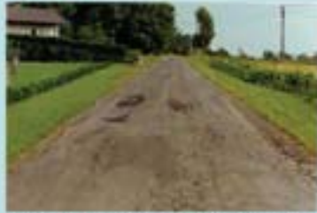
Güterweg Bergen vor Zweitausbau
