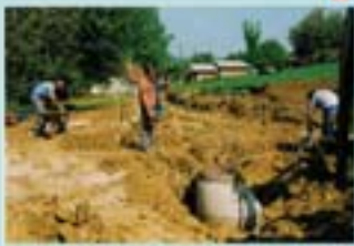
Wasser-Kanal zu Schuch Thomas
