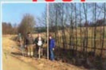
Baubeginn Restkanal Unterneuberg
