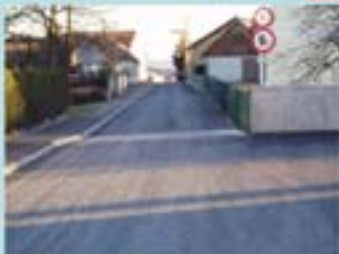
Ausbau Kirchenweg 4. Etappe
