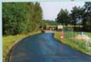
Zementstabilisierung 1. Etappe Bergen - Kreuzung Neuhaus
