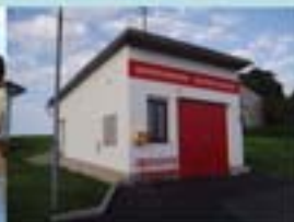
Sanierung FW Haus Bergen
