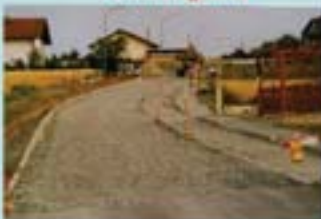
Ausbau Kirchenweg 2. Etappe
