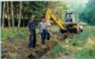
Verbindungsleitung Tubl - Med-Mosta
