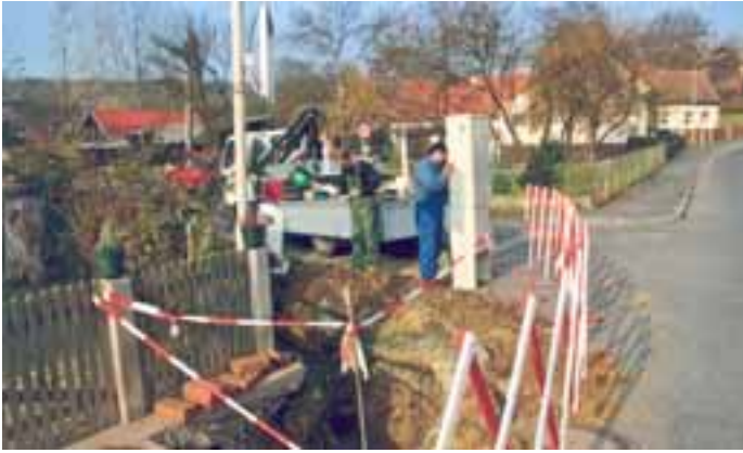
Verlegung Steuerungsanlage Straßenbeleuchtung
