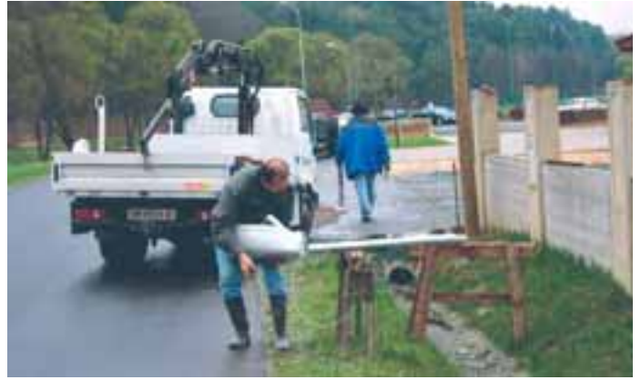
Straßenbeleuchtung für Gewerbegebiet
