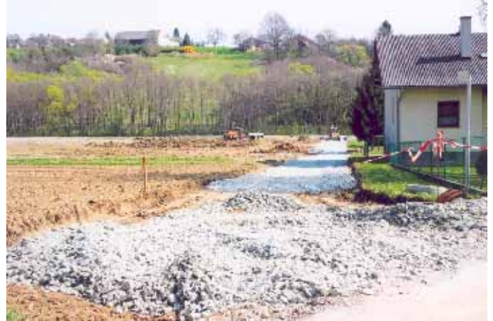
Baumaßnahmen Gemeinde: Kanal, Wasser und Wegebau
