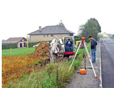
Hausanschlüsse Kanal und Wasserleitung
