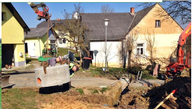
Hausanschlüsse Kanal und Wasserleitung
