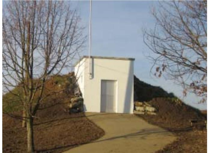
Der Hochbehälter mit einem Fassungsvermögen von 400.000 Litern Trinkwasser bleibt das zentrale Element der Wasserversorgung von Neuberg. Die Vorratsspeicherung ist besonders zur Versorgungsüberbrückung nach Stromausfällen sowie zum Ausgleich bei Spitzenentnahmen unabdingbar.
