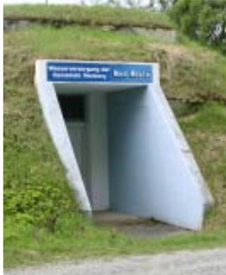
Der **"Kotschak-Brunnen"** ist ein zuverlässiger Wasserlieferant, der ohne aufwändige Steuerung auskommt. Im Jahr 2010 lieferte dieser 11.425 m<sup>3</sup>, das sind 22,22 % der Gesamtfördermenge. Dieser wird - wie auch der Hauptbrunnen Med Mosta - direkt in das Netz gespeist. Die Überschussmenge wird im Hochbehälter zwischengespeichert.
