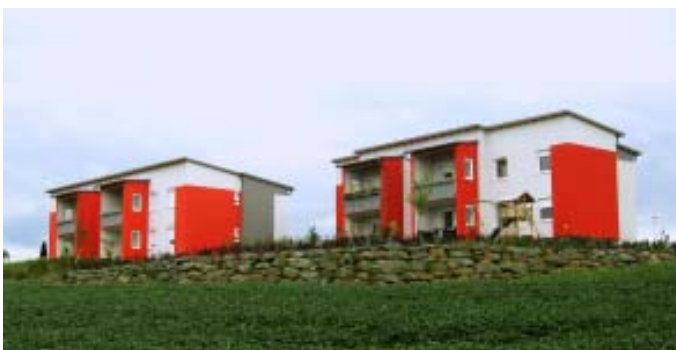
Siedlungen Neue Gasse 1 und 3, errichtet in den Jahren 2008 und 2009
