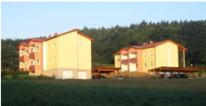
Siedlungen Matthias Semeliker Gasse 5 und Bachgasse 26, errichtet in den Jahren 2006 bis 2009
