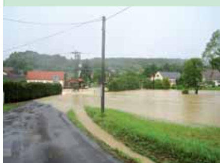
Der Hochwasserschutzdamm Lukabach bewahrte Unterneuberg vor einer Katastrophe. Der Überlauf HQ 5000 (5000-jähriges Hochwasser) springt an.
