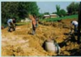
Wasser-Kanal zu Schuch Thomas
