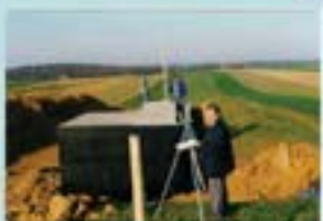
Bau Hochbehälter 200 000 m 3
