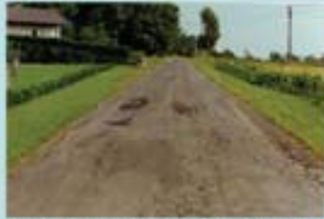
Güterweg Bergen vor Zweitausbau
