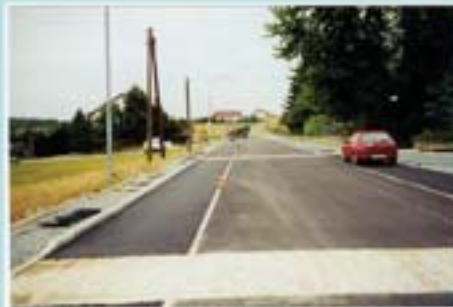
Baubeginn Ausbau Kirchenweg 1. Etappe
