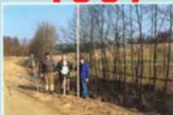
Baubeginn Restkanal Unterneuberg
