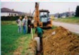
Kabelverlegung Strassenlicht Gewerbegebiet
