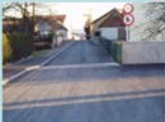
Ausbau Kirchenweg 4. Etappe
