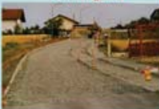
Ausbau Kirchenweg 2. Etappe
