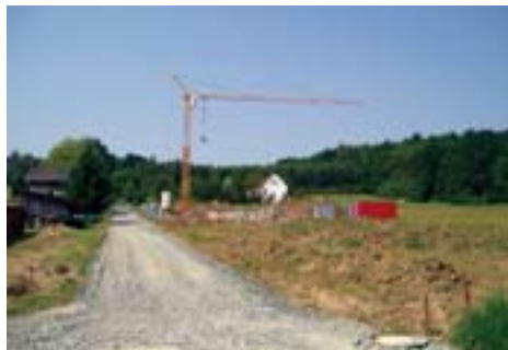
Baubeginn Wohnhausanlage Matthias Semmeliker Gasse in Unterneuberg
