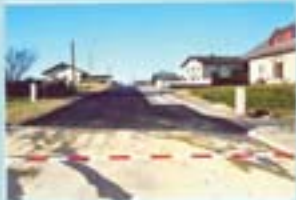
Ausbau Kirchenweg 3. Etappe
