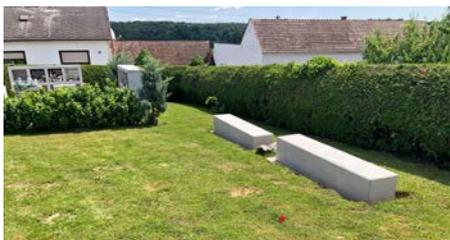
Am Friedhof wird momentan der zweite Urnenhain errichtet. Die Fundamente für die beiden Urnenwände sind bereits betonierte.
